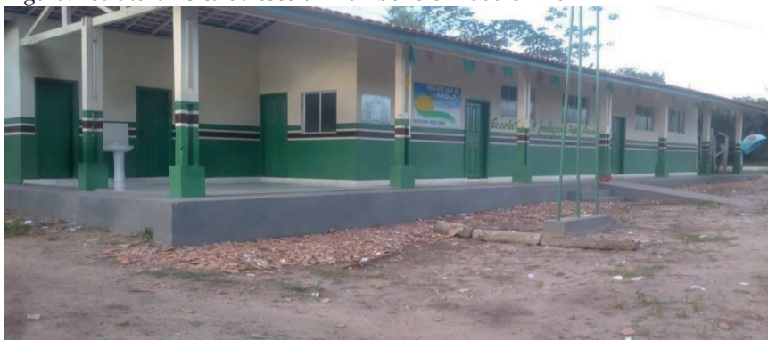
Figura: Estrutura física da escola Anambé reformada em 2017
